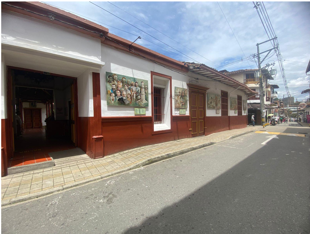
Imagen 3. Ala antigua y ala modernizada. Fuente: Elaboración propia.
